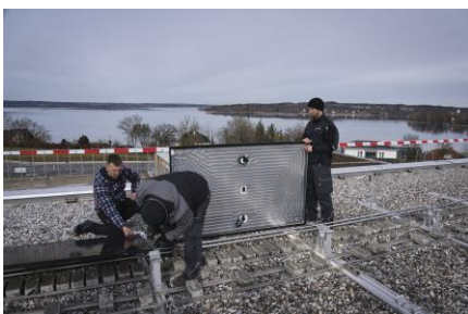
Bild 02: Insgesamt haben die Monteure 228 Photovoltaik-Thermie-Module der TWL-Technologie GmbH installiert.
