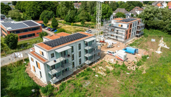
Bild 01: Serienmodell: Generalunternehmer Gröbbel will seine seriellen Holzbauten künftig standardmäßig mit PVT-Anlagen ausstatten. Copyright: ISFH
